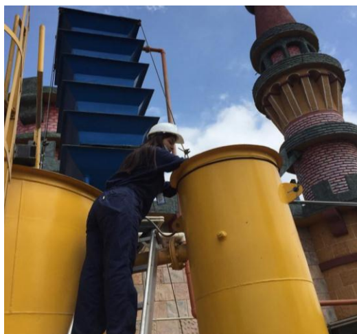
Ilustración 4. Toma de muestra al afluente del tanque de equilibrio Fuente: Autores.
