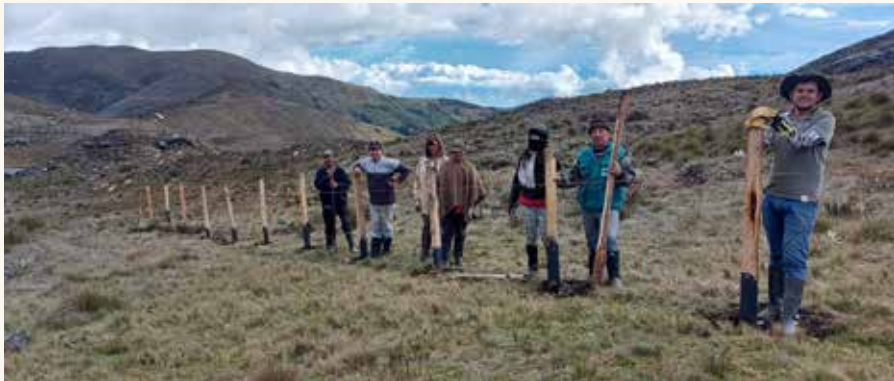
Figura 1.3. Instalación de cercado perimetral.
